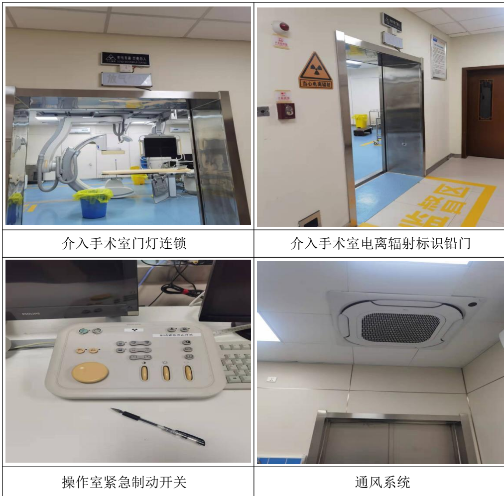
图 2-3 验收现场部分照片
